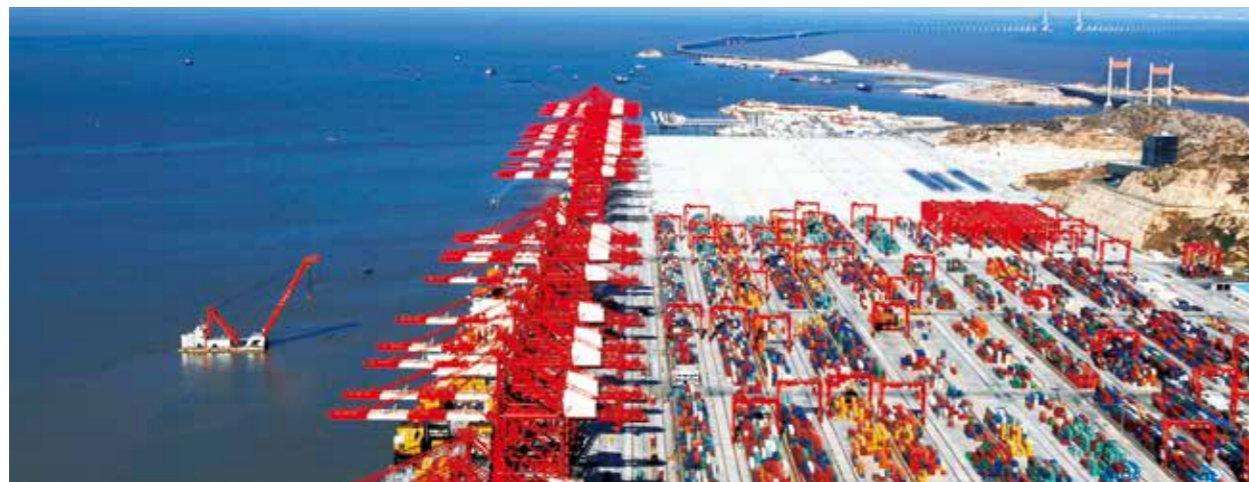
上海洋山深水港区工程
