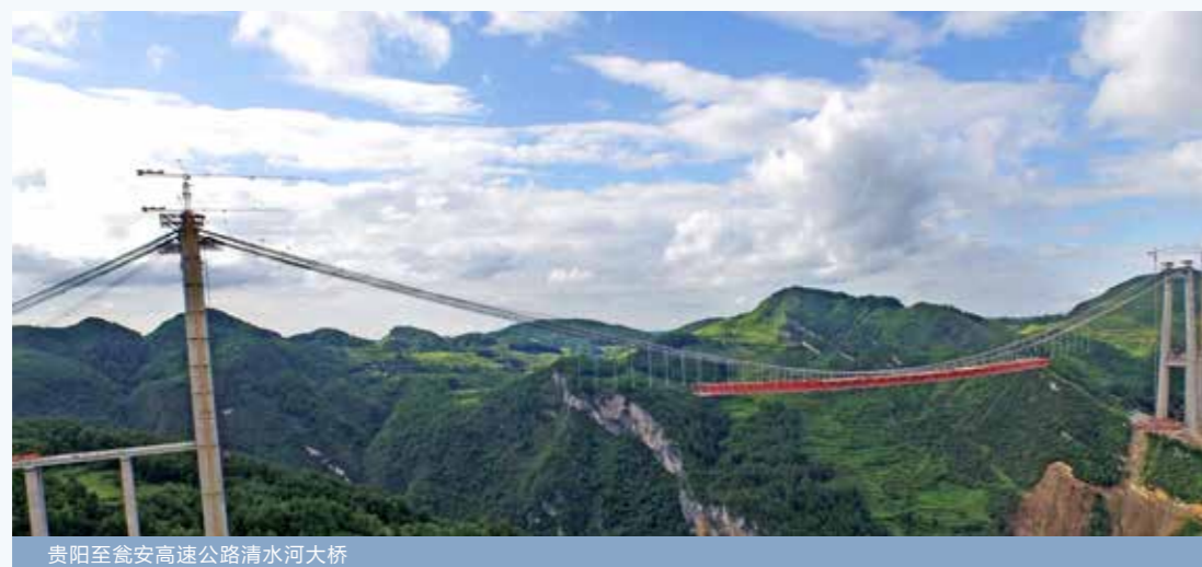
贵阳至瓮安高速公路清水河大桥
