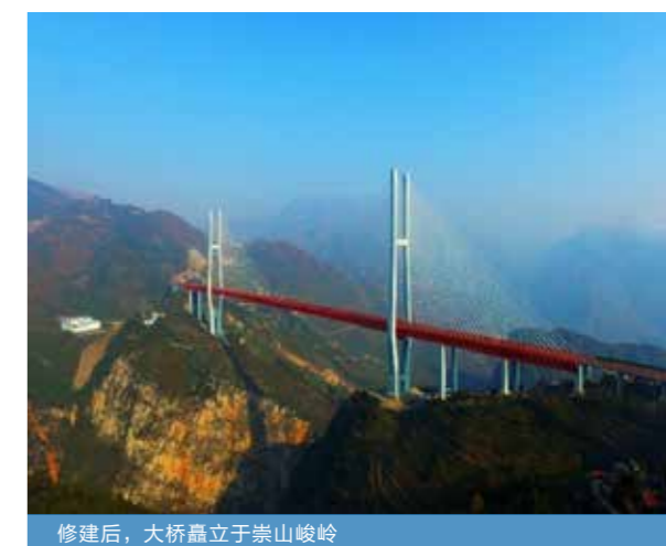
修建后，大桥矗立于崇山峻岭
