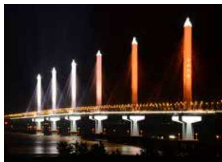
嘉绍大桥荣获 2016 年国际桥梁大会金奖、2016 年国际道路联盟 (IRF) 全球道路成就奖
