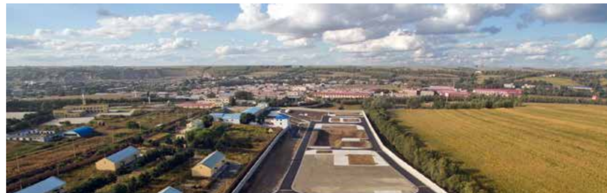
哈尔滨日遗化武移动式销毁场建设项目
