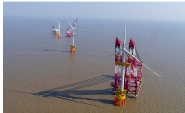
国电舟山普陀6号海上风电场2区工程
