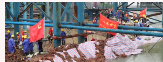
中交路建引江济淮项目部参加抗洪救灾工作
