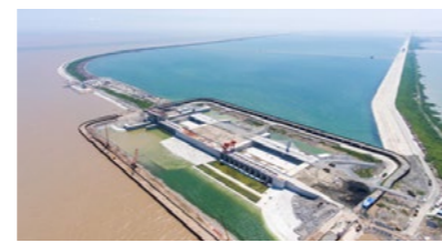
温州市瓯飞一期围垦工程（北片）
