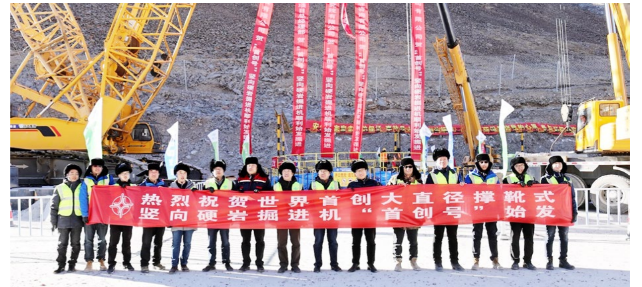
超大直径竖向掘进机“首创号”顺利下线
