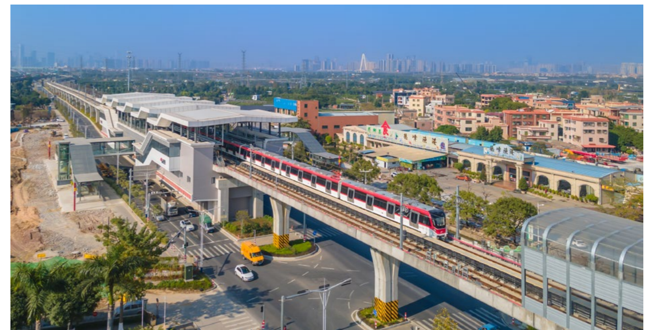
佛山地铁2号线一期工程
