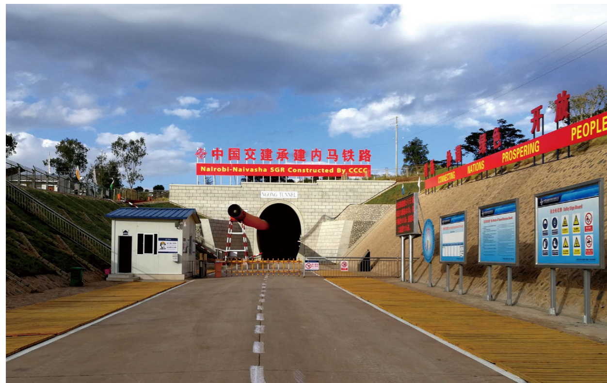
内马铁路一期恩贡山隧道 Ngong Tunnel of SGR Phase 2A
