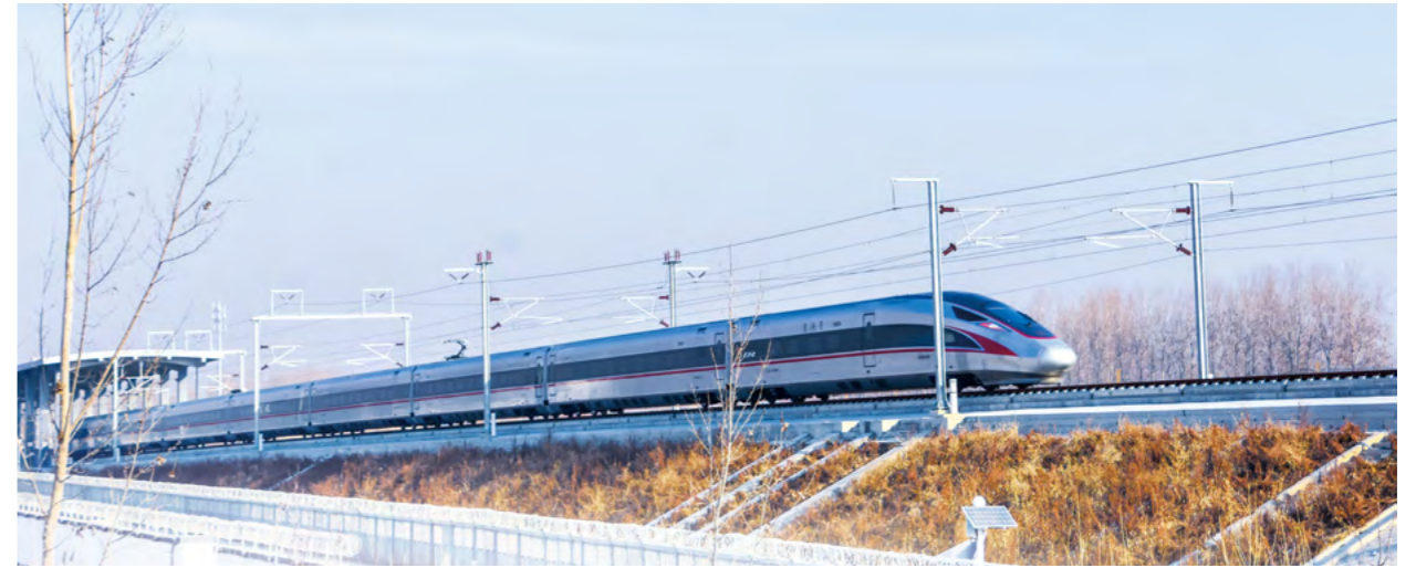
京雄城际铁路
