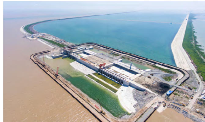
温州市瓯飞一期围垦工程（北片）
