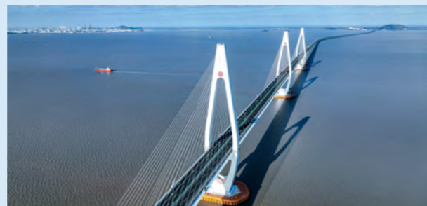
舟岱跨海大桥——全长约28公里，是我国最长的连岛高速公路和规模最大的跨海桥梁群的一部分
