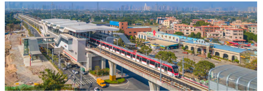
佛山地铁 2 号线一期工程
