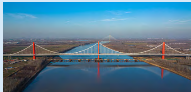
济南黄河凤凰大桥——全长3,788米，为三塔自锚式悬索桥，桥面整幅宽61.7米，是最宽的跨黄河大桥
