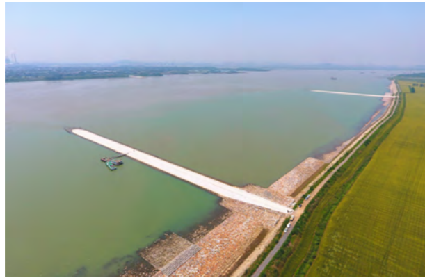
长江南京以下12.5米深水航道二期工程
