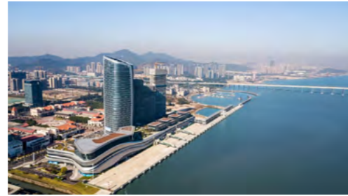
广州南沙国际邮轮码头作为全国规模最大的邮轮母港综合体的重要组成部分，顺利通过竣工验收
