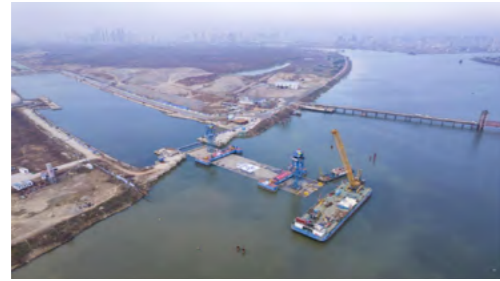
中交二航局投资建设的襄阳市东西轴线（襄江大道）鱼梁洲过江隧道为国内目前整体规模最大的内河沉管隧道
