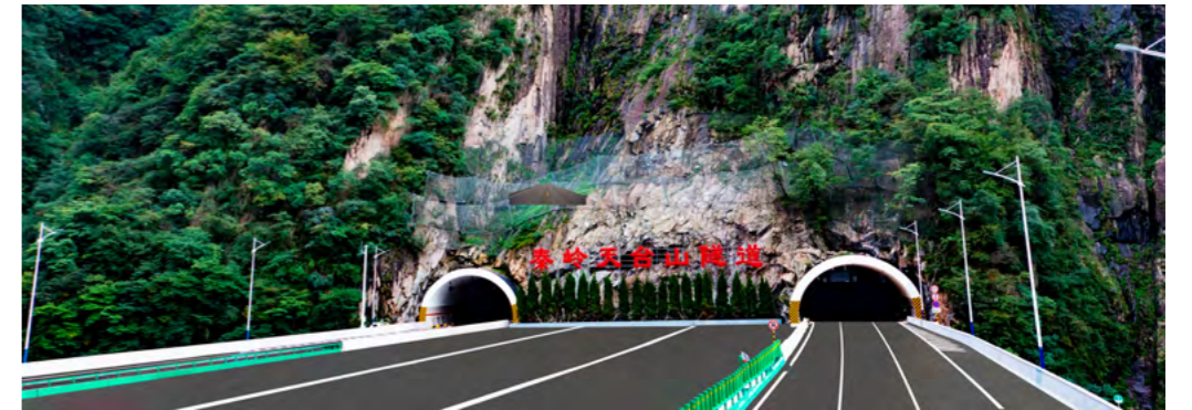
秦岭天台山隧道
