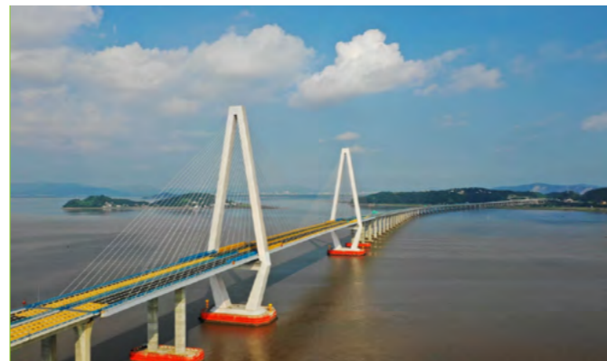
浙江省乐清湾大桥及接线工程
