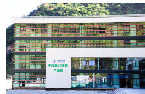
中交怒江建筑产业园
