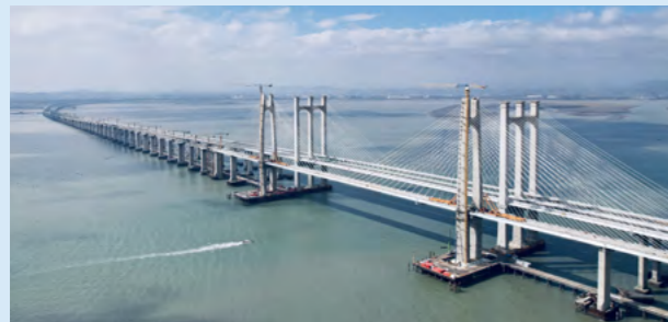
福厦高铁泉州湾跨海大桥——全长约20公里，海上桥梁长8.96公里，主桥长800米、主跨400米，为双塔双索面钢混结合梁半漂浮体系斜拉桥
