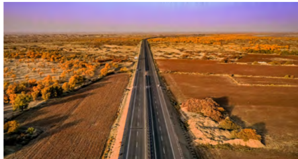
乌尉公路尉犁至若羌高速公路
