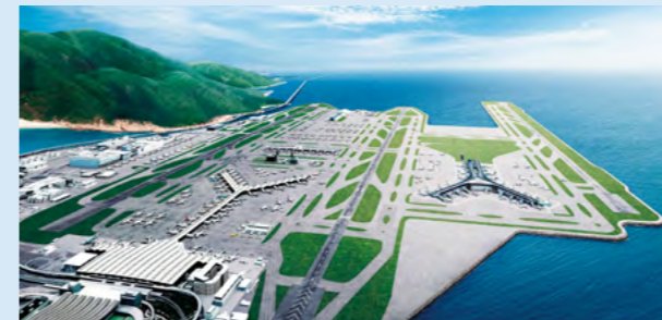
9月7日，香港国际机场第三跑道填海工程跑道铺设工程竣工。该工程投入使用后将极大提升香港国际机场的运量，巩固香港国际航空交通枢纽地位，加快推动香港经济社会发展
