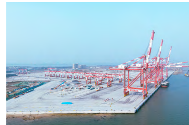
粤港澳大湾区首个全自动化码头——广州南沙四期自动化码头
