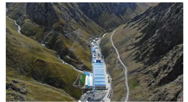
项目作业平台用钢板铺装代替混凝土浇筑
