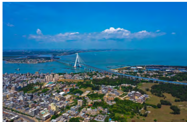
海南铺前大桥（海文大桥）
