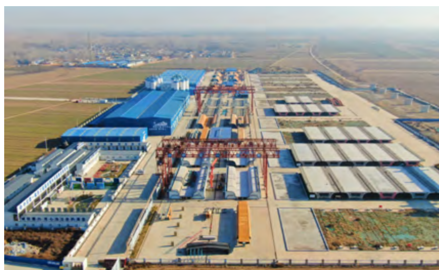
河北石衡沧港城际铁路项目
