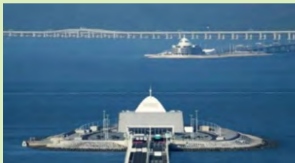
港珠澳大桥主体工程岛隧工程
