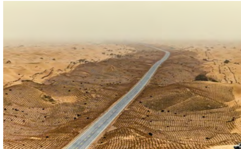
新疆乌尉公路包PPP项目S254线尉犁至且末公路
