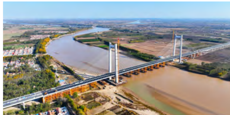
沾临黄河特大桥
