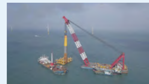
复杂地质条件海上风电基础施工与风机安装关键技术
