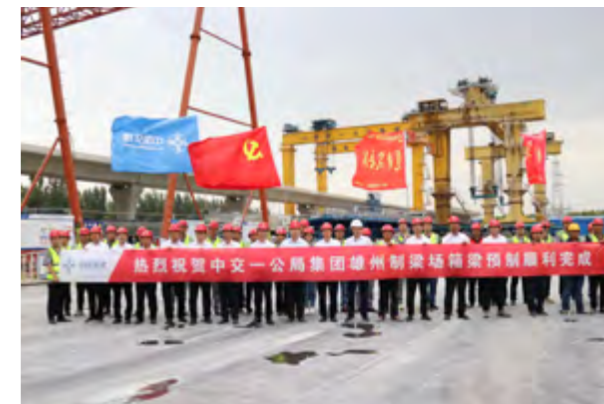
雄安新区至北京大兴国际机场快线 R1 线雄州制梁场箱梁预制全部完成
