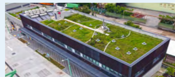
水务处理类最佳项目——香港新围污水处理厂一期
