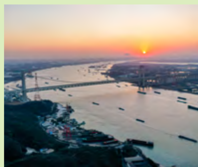
新建连云港至镇江铁路五峰山长江特大桥
