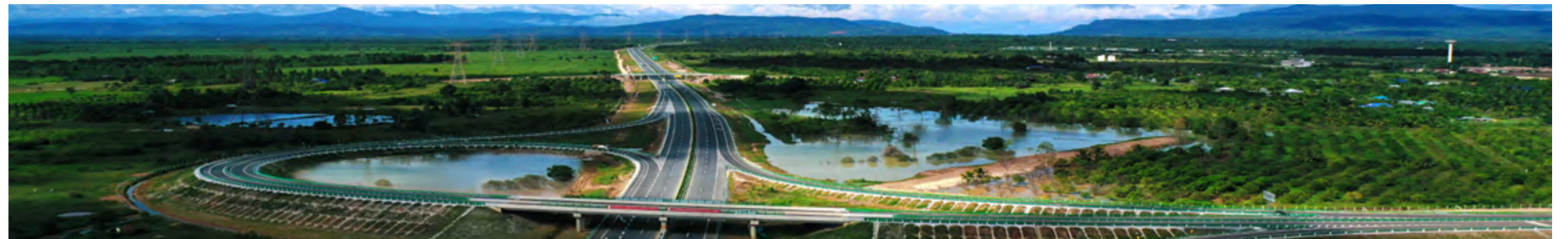
连接柬埔寨首都金边和最大深水海港西哈努克港（西港）的金港高速
