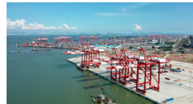
粤港澳大湾区自动化码头
