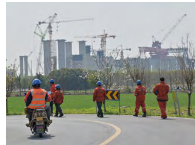
建筑者们穿行在常泰长江大桥的樱花大道
