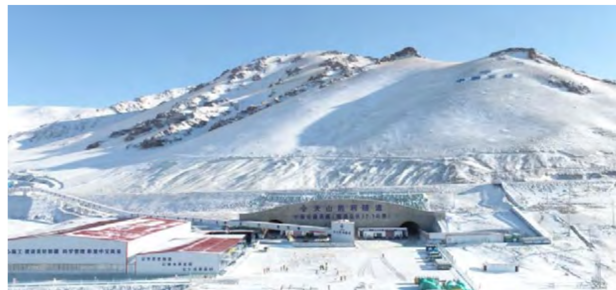
天山胜利隧道出口端
