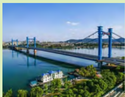
襄阳庞公（凤雏）大桥
