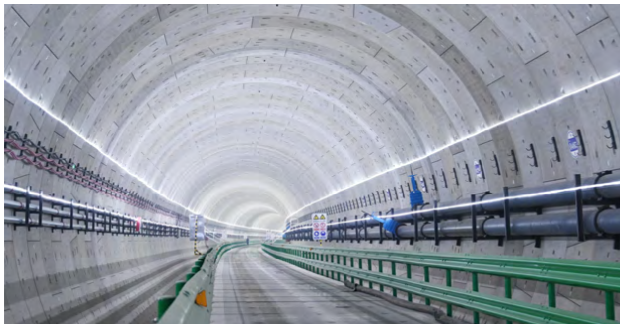
北京东六环改造工程东线隧道
