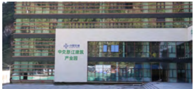
中交怒江建筑产业园
