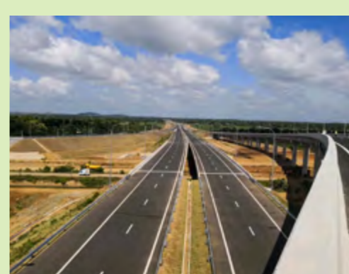
斯里兰卡南部高速延长线项目 2/3/4 标段新建工程
