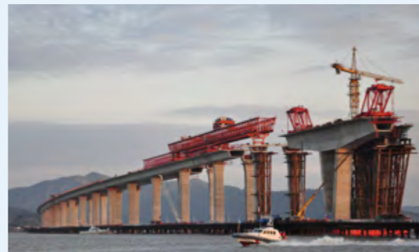
一种变截面节段梁短线预制拼装方法（乐清湾大桥）
