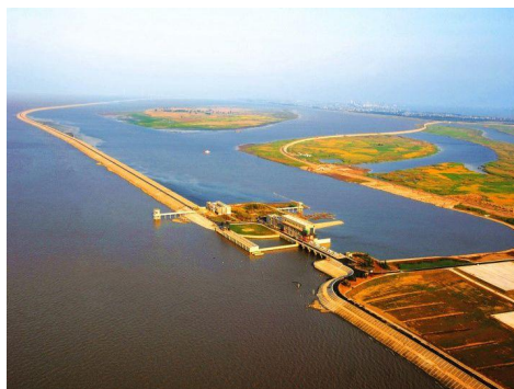
上海青草沙水源水利枢纽工程
