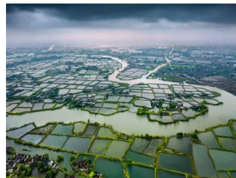
浙江省“百漾千河”综合治理项目
