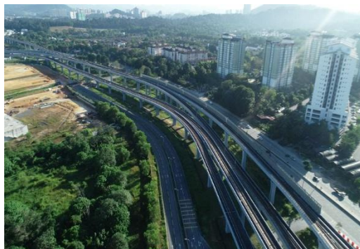
吉隆坡地铁二号线一期工程
