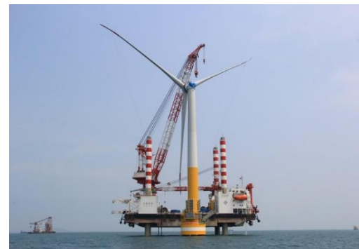
海上风电安装作业现场
