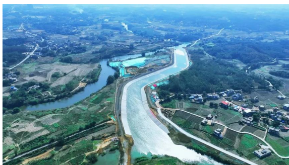
广西平陆运河航道工程
