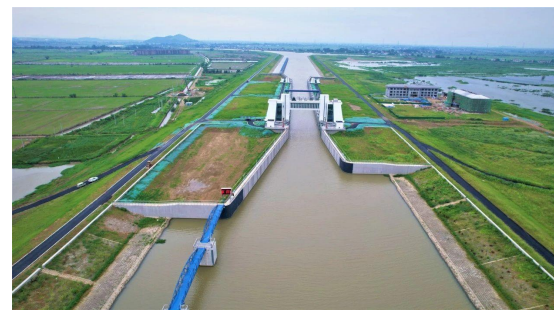
安徽引江济淮一期工程
