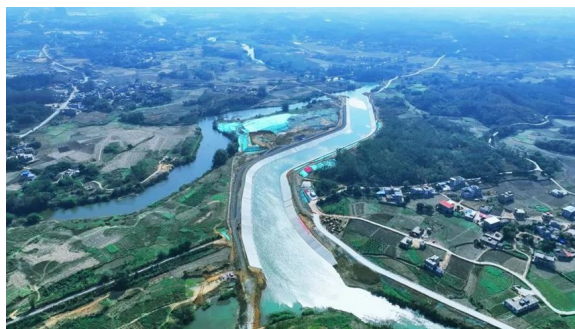
广西平陆运河航道工程
